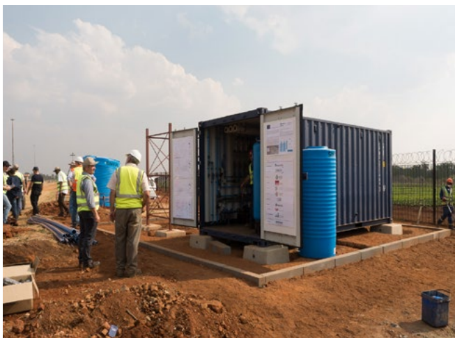
Beim Aufbau der Wasserreini- gungsanlage. © Fraunhofer IST
